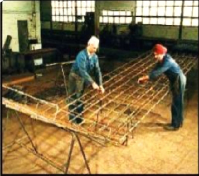
تجهيز حديد التسليح لبلاطة سابقة الصب
