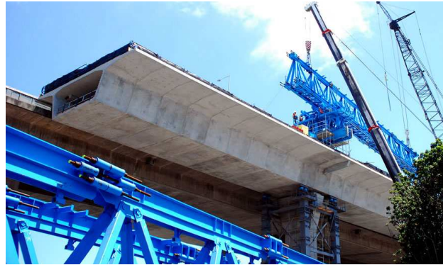
الشكل (٢٨): الصب بالموقع لجسر ذو عارضة صندوقية
