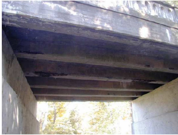
T الشكل (١١): كمرات بسيطة الإستناد مصبوبة مع البلاطة في آن واحد لتشكيل مقطع
