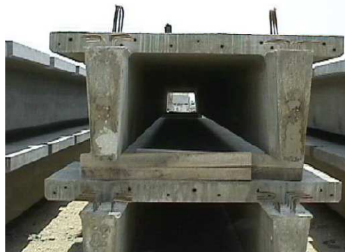
الشكل (١٣): مقطع تيه مزدوج مسبق الصنع
