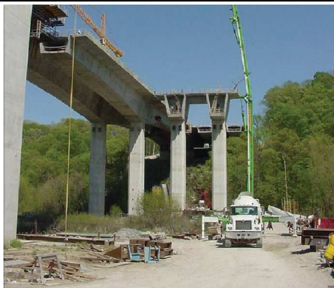
الشكل (٣٠): جسر ذو مقطع بعارضتين صندوقيتين
