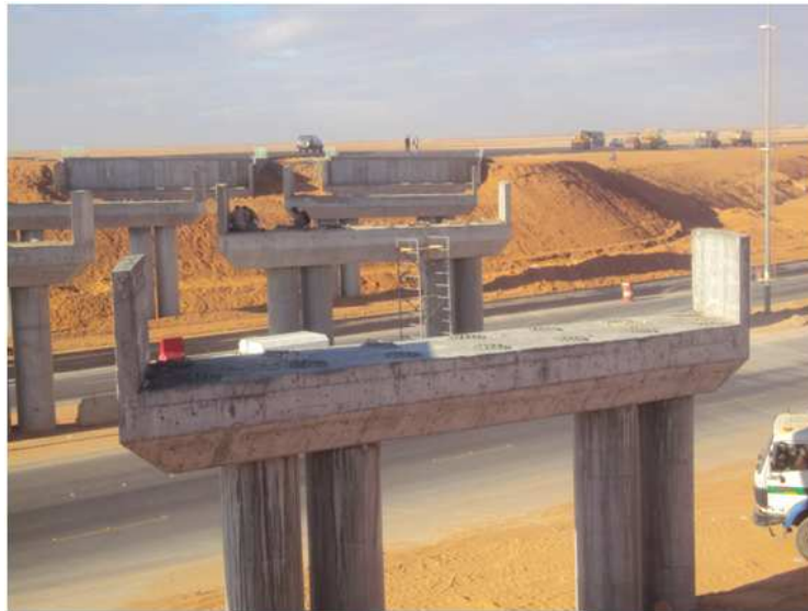
الشكل (٤٤): ركيزة الأعمدة ذات التاج
