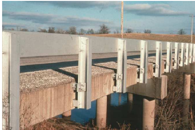
الشكل (١٠): أحد جسور البلاطات مسبقة الصنع مسبقة الإجهاد
