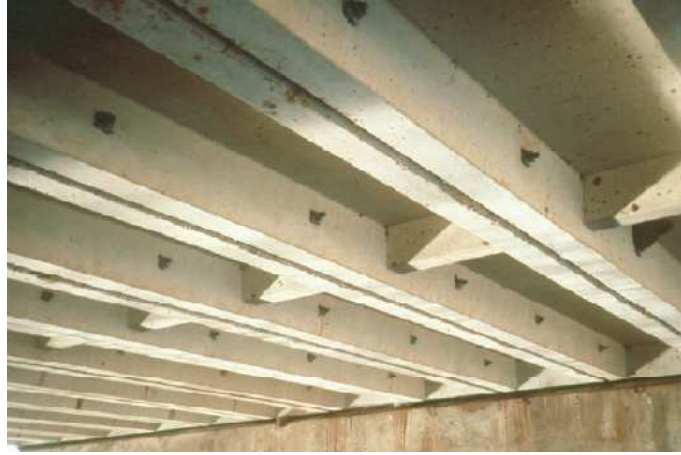
الشكل (٢٠): كمرات متجاورة ذات مقطع قناة
