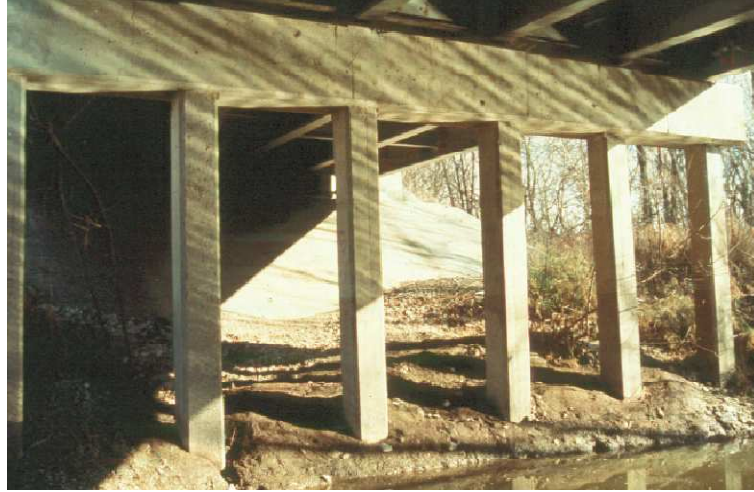
الشكل (٤٥): ركيزة الخوازيق ذات التاج
