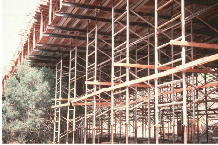
الشكل (٢٨): الصب بالموقع لجسر ذو عارضة صندوقية
