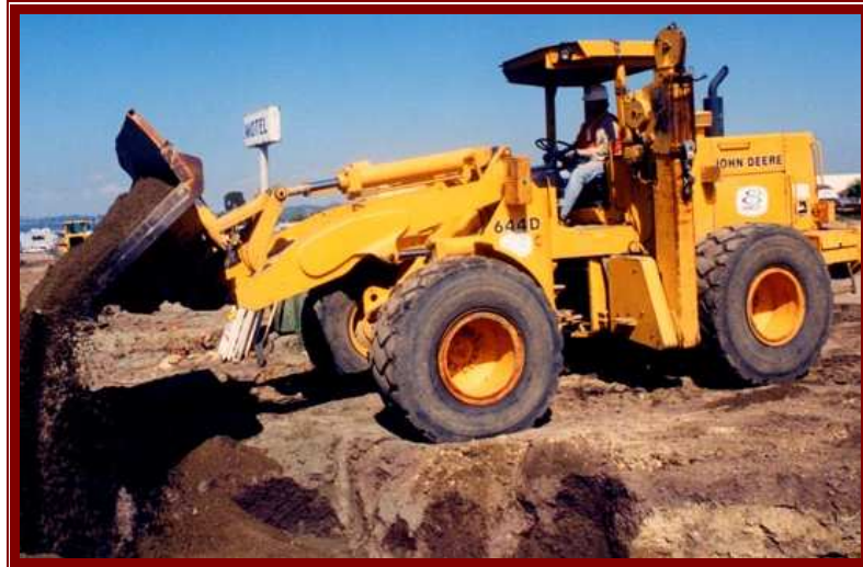
شكل ( ٣-٣٩ ) إستخدام اللودر فى ردم الحفر وتشوين الأتربة
