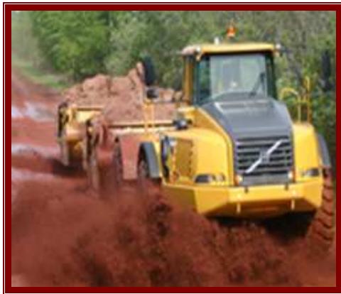
شكل (٣-٥٤): ترطيب التربة
