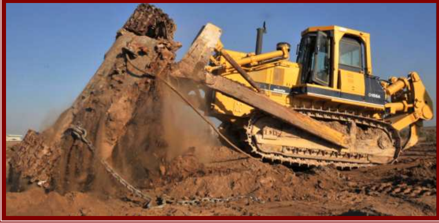
شكل (١٨-٣ أ): شد الجذع ثم جذبه حتى يقتلع
