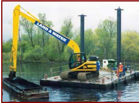
٦- الإرتكاز على عوامات لتطهير مجارى المياه العريضة وتفريغ المراكب الصغيرة
