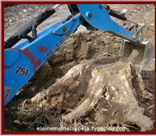
شكل (١٨-٣ ب): الحفر حول الجذوع وتكسييرها لإقتلاعها
