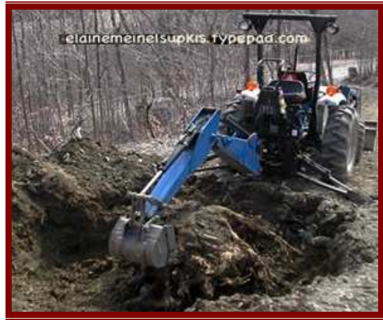
شكل (١٨-٣ ب): الحفر حول الجذوع وتكسييرها لإقتلاعها
