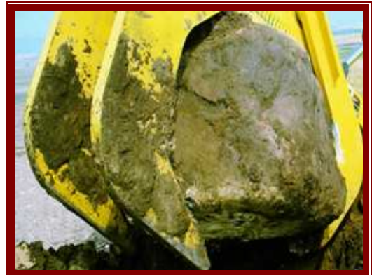
شكل (٣-٢١): إستخدام البلدوزرات ذات الشبكات الأمامية أو الكلابيات لنقل الأحجار المتوسطة لخارج حدود منطقة العمل
