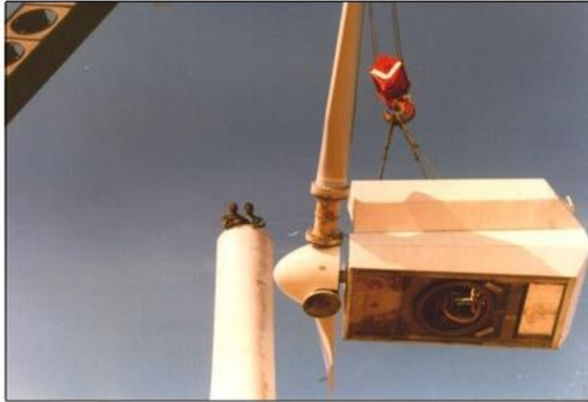
الشكل رقم (٢٤) : رفع الناسيل فوق البرج
