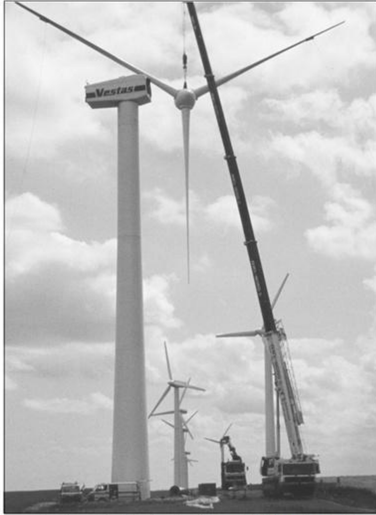
الشكل رقم (٢٥) : تجميع الريش على الارض ورفعها
