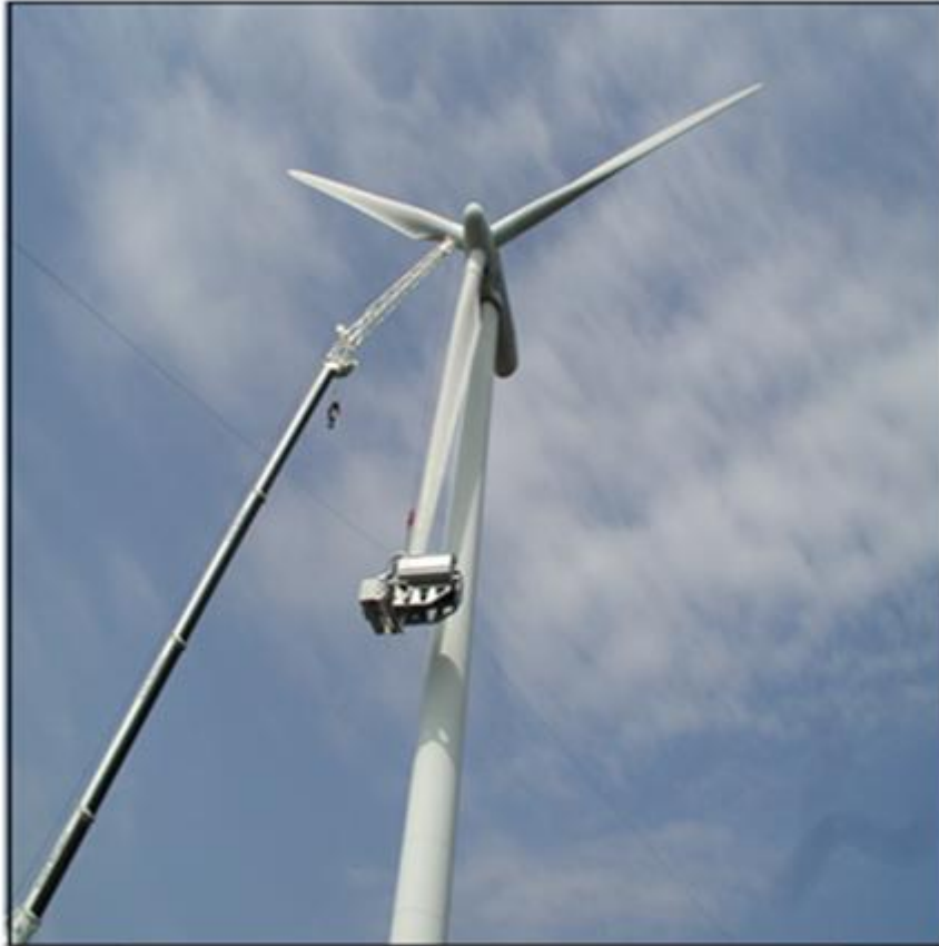
الشكل رقم (٨) : تنفيذ عملية غسيل الريش
