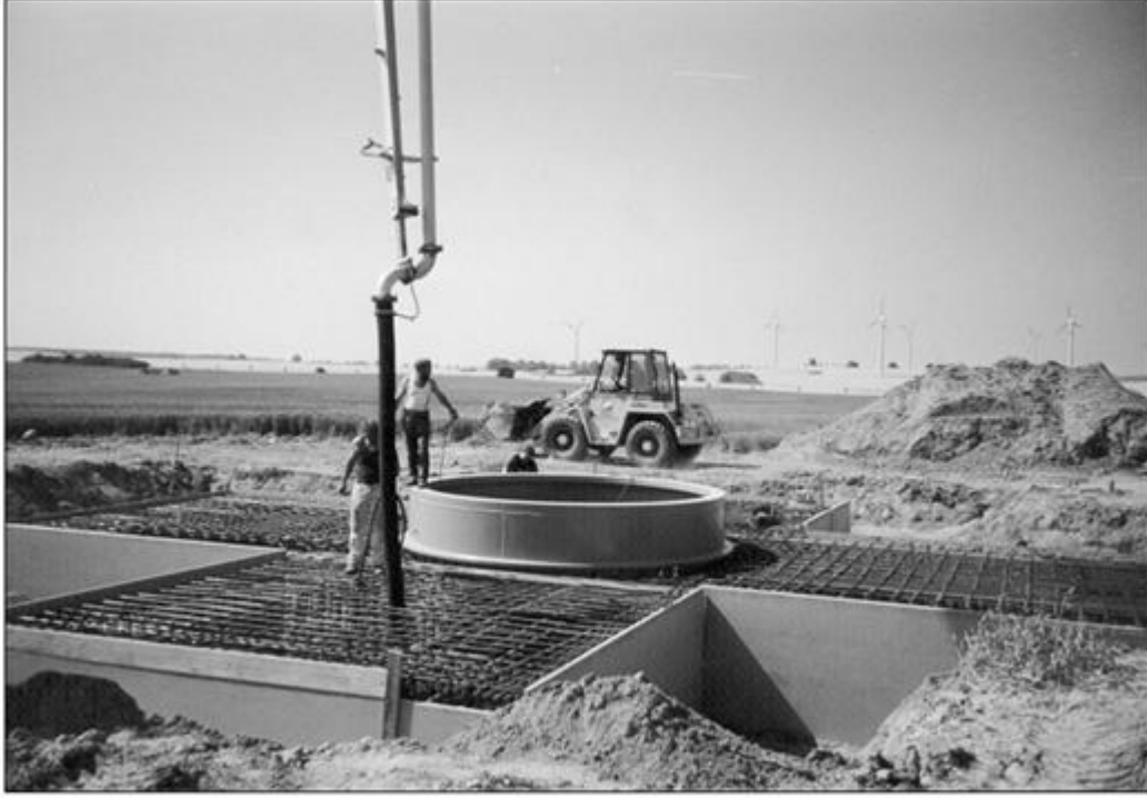
الشكل رقم (٥٢) : تنفيذ القاعدة الخرسانية
