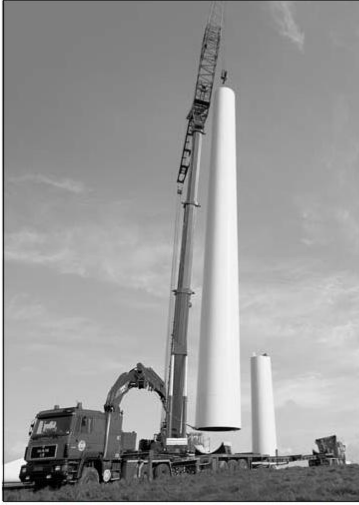
الشكل رقم (٢٦) : رفع البرج لتركيبه على القاعدة
