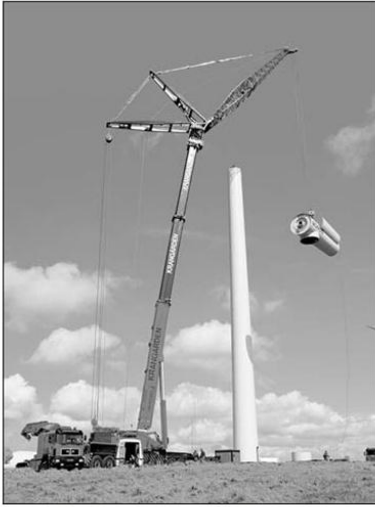
الشكل رقم (٢٨) : رفع الناسيل الى قمة البرج
