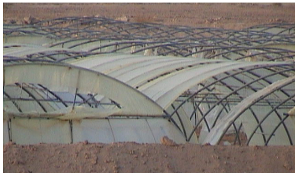
شكل (٧): التلف والتعري لمادة البولي إيثيلين
