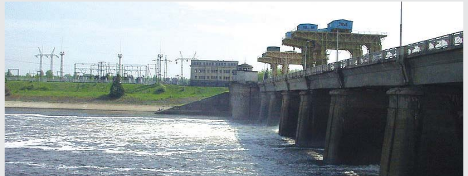
■ محطة مائية لتوليد الكهرباء.
