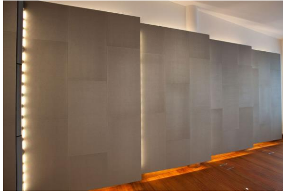
شكل (2.6): ألواح الألمنيوم ذات السطح الخشن (Sound absorption panel Aluminum – Calme)
