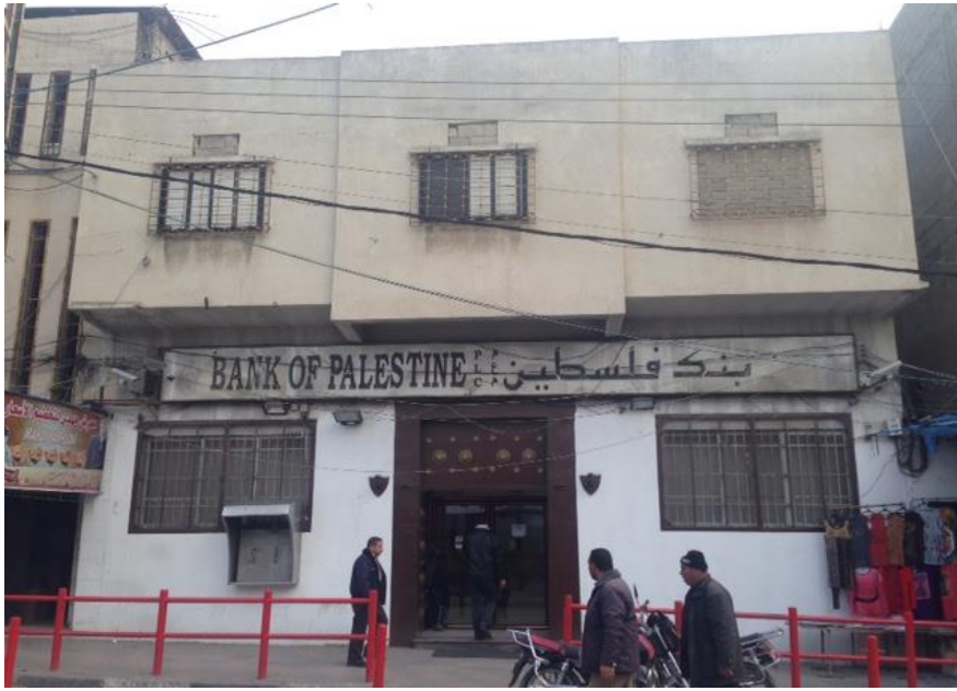
شكل (5.45): استخدام القصارة والدهان ، واستخدام الابواب الحديدية.
