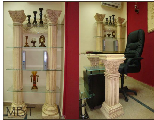
شكل (2.37): استخدامات مادة GRC في الفراغات الداخلية وطريقة التشكيل
