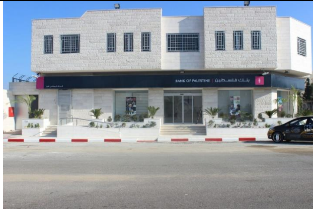
شكل (5.41): استخدام حجر المطبة والملطش، استخدام زجاج السكوريث والنواح الكومبوزيت وبلاستيك الاكريليك
