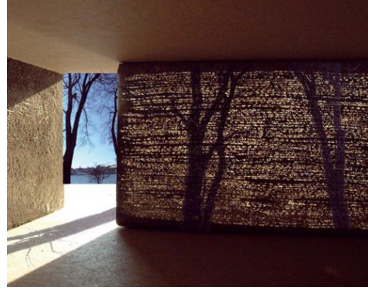
شكل (2.7): خلطة الاسمنت الممزوج مع الألياف الزجاجية (Concrete with glass fibers - Litracon)
