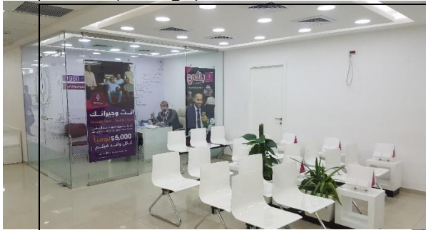
شكل (5.21): استخدام زجاج السيكروريت كقواطع واستخدام دهان الفاينل سيلك. ( فرع الرمال)
