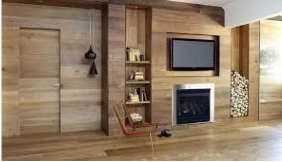
شكل (3.31): يوضح استخدام الخشب كمادة تشطيب للأرضيات والحوائط.
