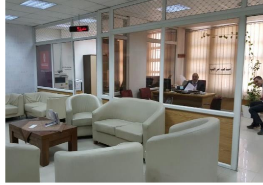
شكل (5.24): استخدام قواطع الألومنيوم كفواصل بين الفراغات
