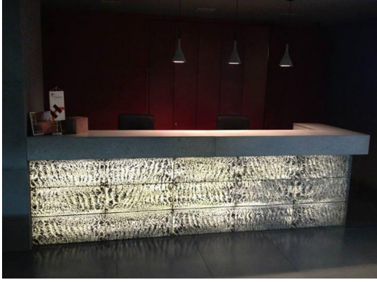
شكل (2.8): كاونتر استقبال مصنوع من خلطة الاسمنت الممزوج مع الألياف الزجاجية (Litracon)
