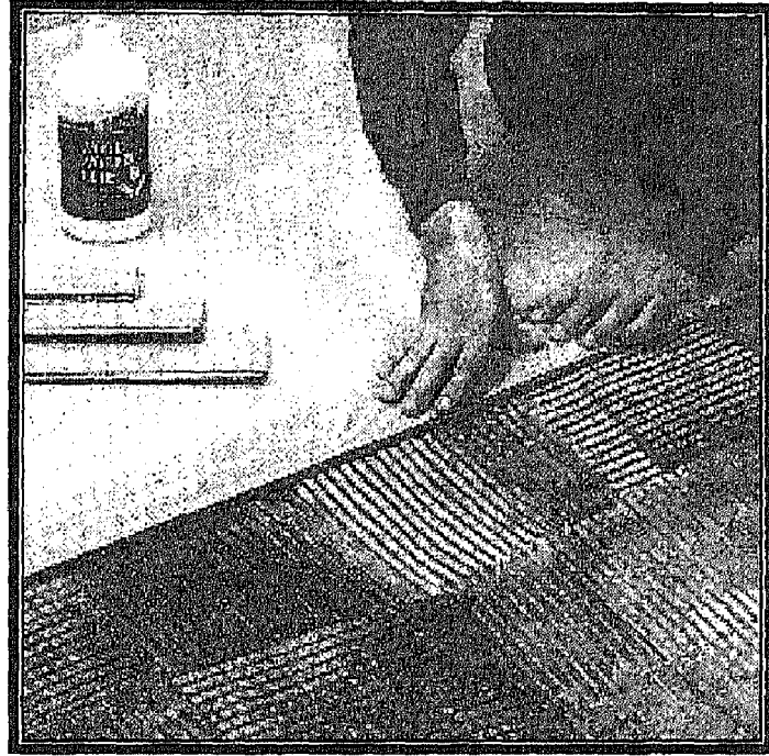
الشكل يوضح وضع المادة اللاصقة على الارض بواسطة مشحاف مسنن وتثبت القطع الخشبية عليها بواسطة المجرى والافريز والغراء
