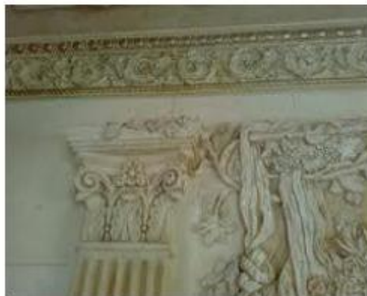
استخدام الـ (GRC) في الواجهات و الأعمدة و الكرانيش
