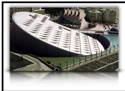
المبنى من الخارج
