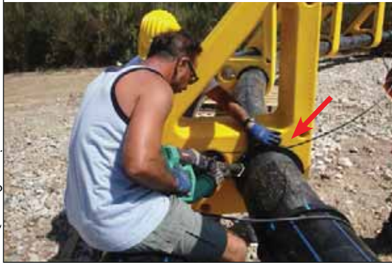
اللوحة 46 تثبيت الأهلة في مواضعها بواسطة مكابح HDPE على الأنبوب الداخلي (السهم الأحمر)، أما الأنبوب الخارجي فهو غير مزود بمكابح. تُلَحَم المكابح على أنبوب القفص باستخدام آلة لحام HDPE محمولة باليد
