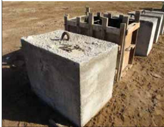
اللوحة 7 بمجرد أن يمتلئ القالب الخشبي بالاسمنت وتقسو الكتلة يمكن إزالة القالب وترك الكتلة لتجف لبضعة أيام
