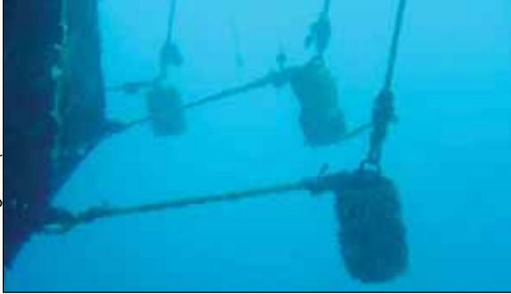
اللوحة 34 سلاسل دعامة مسمارية مستخدمة كمُغْرِقات. تُفضّل السلاسل في الاستخدام لموازنة توتر الشبكة بسبب الوزن الأكبر لل فولاذ في الماء مقارنة بالإسمنت والحجارة أو المواد لأخرى
