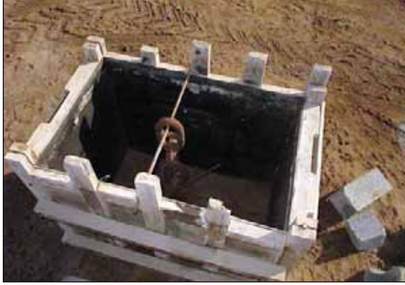
اللوحة 7 بمجرد أن يمتلئ القالب الخشبي بالاسمنت وتقسو الكتلة يمكن إزالة القالب وترك الكتلة لتجف لبضعة أيام
