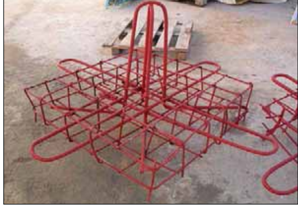
اللوحة 6 تفصيل لسلسلة الدعامه المسماية المستخدمة في القالب الخشبي. لاحظ القضيبين الحديديين المضافين على المربط الأسفل
