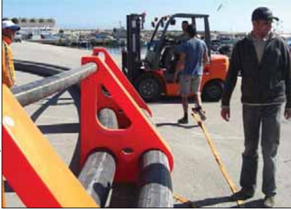
اللوحة 46 تثبيت الأهلة في مواضعها بواسطة مكابح HDPE على الأنبوب الداخلي (السهم الأحمر)، أما الأنبوب الخارجي فهو غير مزود بمكابح. تُلَحَم المكابح على أنبوب القفص باستخدام آلة لحام HDPE محمولة باليد
