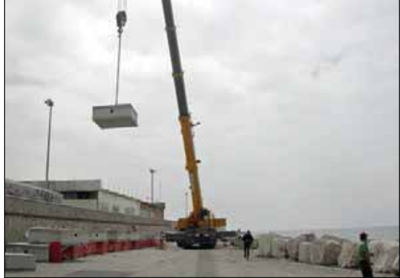
اللوحة 8 إغراق الكتلة الاسمنتية. ترفع الكتلة الاسمنتية إلى المكان باستخدام رافعة المركب أو الرافعات
