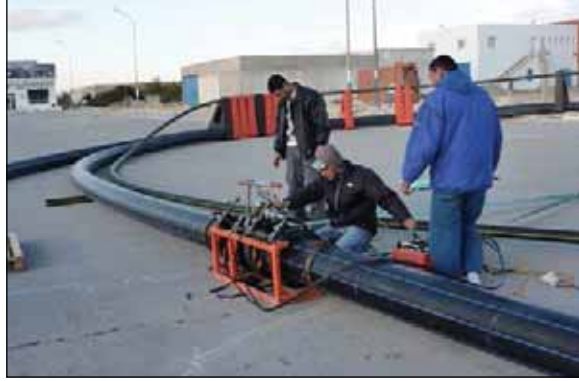
اللوحة 44 عملية اللحام المُنَاكِب الأخيرة لنهائي الأنبوب، وعقب عملية اللحام هذه يكون الأنبوب الأول من طوق القفص قد أُغْلِقَ
