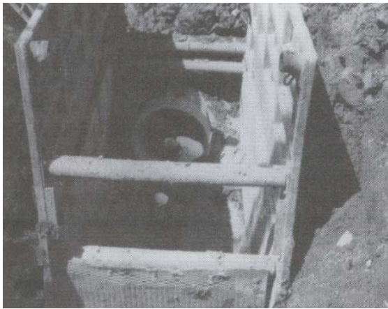
شكل (٩.٤): مراحل تنفيذ مواسير التصريف.
