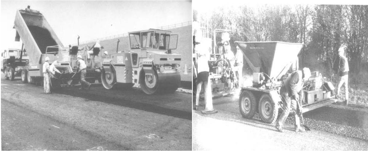
شكل (٢,٤) عملية إنشاء الرصف المرن.
