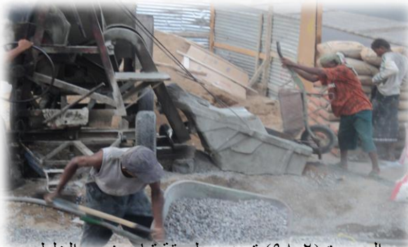
الصورة (٩٨-٢) توضح طريقة قياس نسب الخلط في الموقع-الباحث ٢٠١٢-٢٠١٣م
