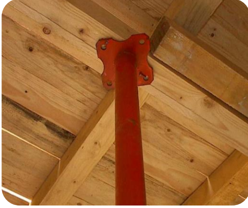
صورة (١٥٨-٢) توضح الرأس العلوية للماسورة الداخلية
