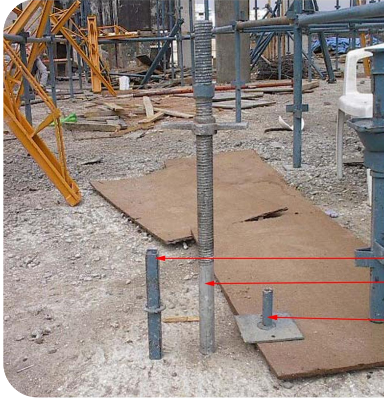
صورة (١٦٤-٢) توضح وصلات القوائم في الشدة المعدنية (المؤسسة العامة للتعليم الفني والتدريب المهني "ورش شدات ووحدات تسليح باب الشدات المعدنية، المملكة العربية السعودية)
