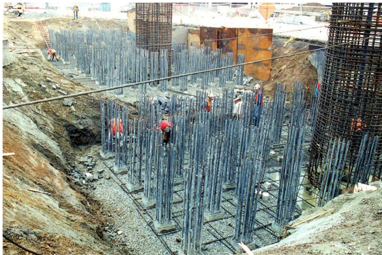
الصورة (٤٢-٢) توضح الخوازيق فوق الأرض (الإنترنت)
