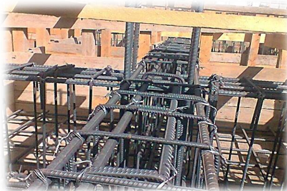
الصورة (٩٣-٢) توضح حديد الميدة مع حديد الرقاب دراسة سابقة - رأفت وآخرون ٢٠١٢-٢٠١٣ م
