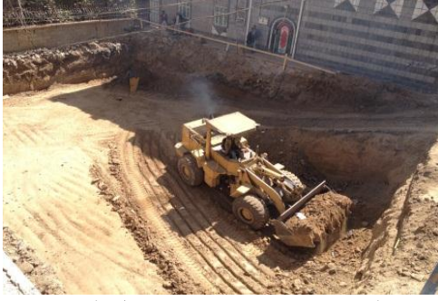
الصورة (٢٤-٢) توضح اعمال الحفر الميكانيكي (الباحث-٢٠١٣-٢٠١٤)
