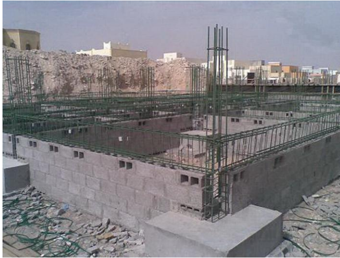
الصورة (٢-٧٠) توضح الكرسي مع القواعد وحديد تسليح الميـد (www.kutub.com ٢٠١٣ - ٢٠١٤م
