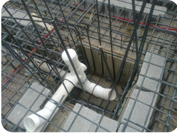
صورة (٢-١٧٩) توضح غرفة التفتيش على السطح حيث تجمع المواسير الهيا ثم تمر الماسورة الى النفق الأفقي، (الباحث ٢٠١٣/٢٠١٤م)
