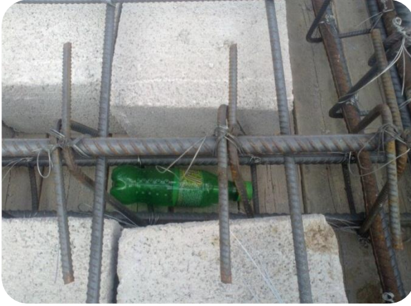
صورة (٢-١٨٨) توضح الشوائب التي يجب إزالتها من السقف قبل الصب (الباحث-٢٠١٣/٢٠١٤م)
