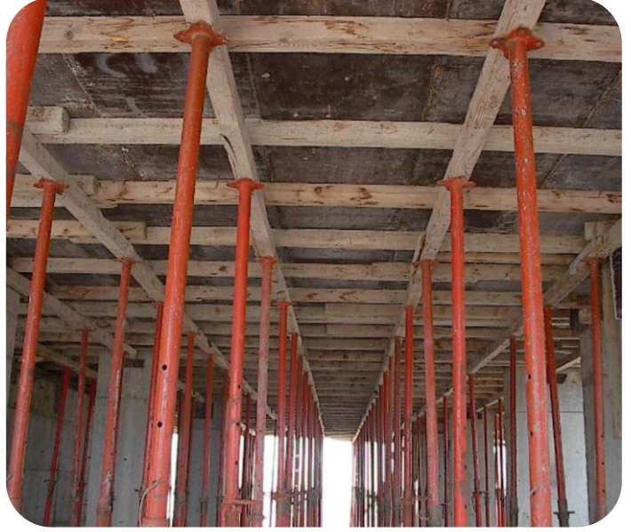
صورة (١٥٧-٢) توضح الشدات الخشبية ذات الدعامات المعدنية المنفردة (المؤسسة العامة للتعليم الفني والتدريب المهني "ورش شدات ووحدات تسليح باب الشدات المعدنية"، المملكة العربية السعودية)
