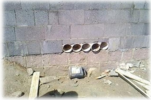
الصورة (٩٦-٢) توضح تنفيذ فتحات الكهرباء في المبددة-
