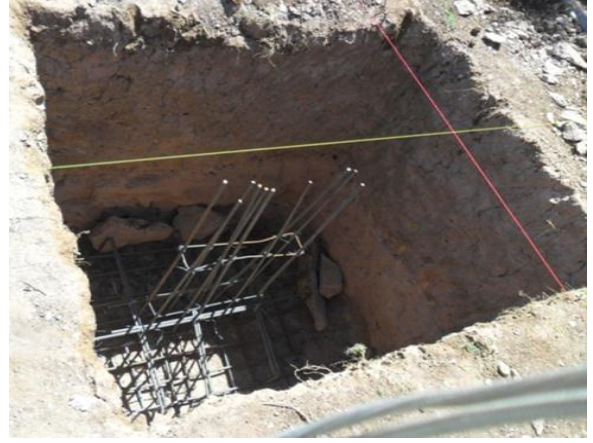
الصورة (٦٦-٢) توضح التسليح العشوائي للرقاب - دراسة سابقة ٢٠١٠ - ٢٠١١ م
