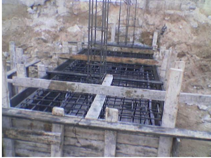
الصورة (٣٦-٢) توضح القواعد المشتركة (دراسة سابقة ٢٠١٢ - ٢٠١٣م)
