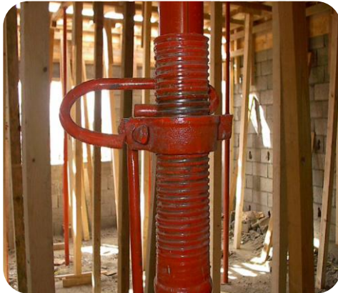
صورة (١٦٠-٢) توضح الجزء الأوسط للقائم ( وصلة الضبط )
