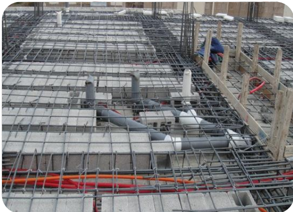
صورة (٢-١٨٧) توضح التمديدات الكهربائية والصحية على السقف (أرشيف الباحث-٢٠١٣/٢٠١٤م)
