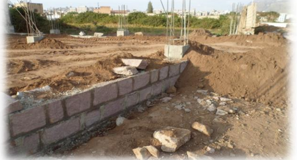
الصورة (١٠٤-٢) توضح أعمال الدفن للأساسات- الباحث ٢٠١٢-٢٠١٣م
