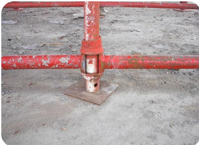
صورة (٢-١٦٢) توضح مكان القواعد الحديدية في الشدة المعدنية (المؤسسة العامة للتعليم الفني والتدريب المهني "ورش شدات ووحدات تسليح باب الشدات المعدنية، المملكة العربية السعودية)
