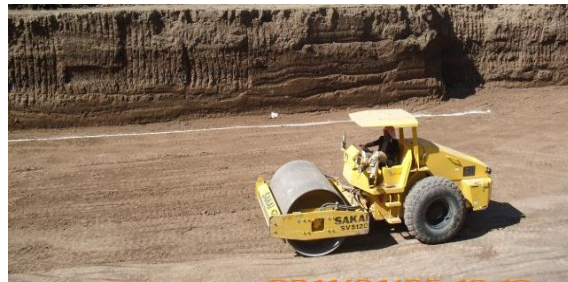
الصورة (٥٠-٢) توضح عملية دك التربة (الباحث- سكن الندوة - إب ٢٠١١ - ٢٠١٢ م)
