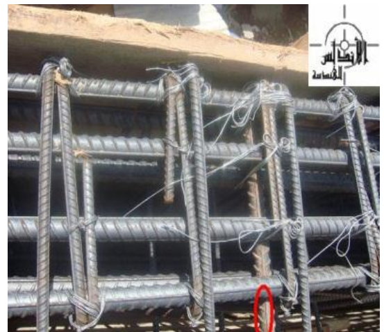
الصورة (٥٦-٢) توضح طريقة تركيب الثخانات (الإنترنت)
