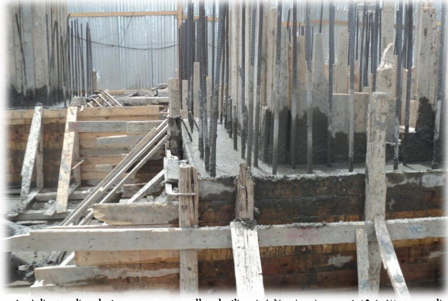
الصورة (٩٤-٢) توضح إخراج إشارات التسليح للمصعد من حديد تسليح الميدة -الباحث ٢٠١٢-٢٠١٣م
