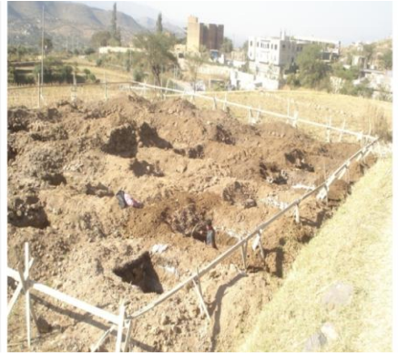
الصورة (٢-١٣) توضح عمل الخنزيرة في الموقع وشد المحاور عليها وحفر القواعد (دراسة سابقة - الزهيري وآخرون ٢٠١٠/٢٠١١م)
