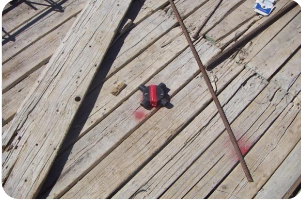
صوره (٢-١٨٣) توضح تثبيت علب الكهرباء - بحث عام ٢٠١٢-٢٠١٣م
