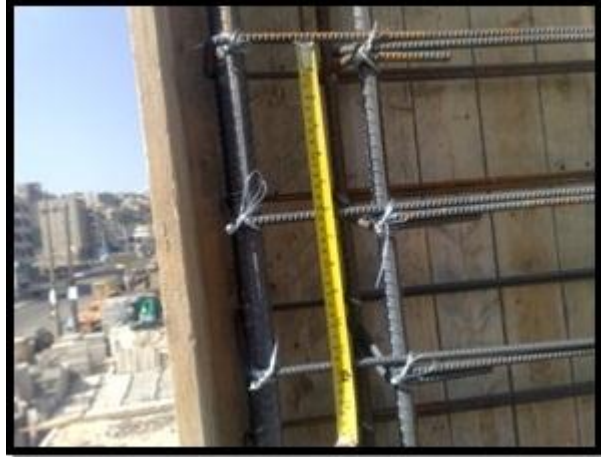
صورة (٢-١٢٥) توضح تسليح الأعمدة حسب الرسومات (دراسة-رافت الجويحي وآخرون (٢٠١١/٢٠١٢م)
