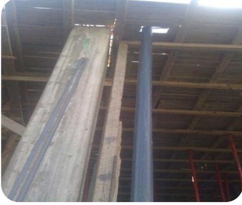
صورة (٢-١٧٦) توضح علاقة ماسورة التمديد من الجدار في التمديد المخفي (الباحث ٢٠١٣/١٤م)
