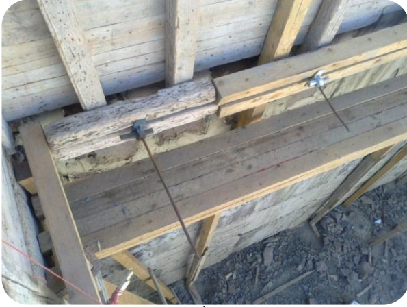
صوره (١٥٦-٢) توضح تأمين الجسور العميقة باستخدام الزراجين (الباحث-تنفيذ جامع قحزہ -اب-٢٠١٣-٢٠١٤م)
