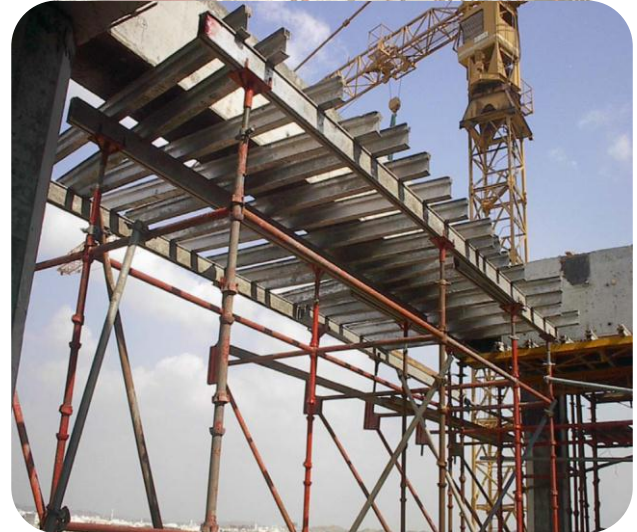
صورة (١٦٦-٢) توضح العرقات و التطاريح (المؤسسة العامة للتعليم الفني والتدريب المهني "ورش شدات ووحدات تسليح باب الشدات المعدنية، المملكة العربية السعودية)
