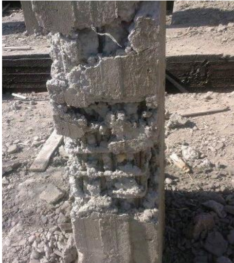
صورة (٢-١٣٧) توضح تعشيش العمود بسبب كبر حجم حبيبات الركام.(فيس بوك شبكة المعرفة الهندسية)
