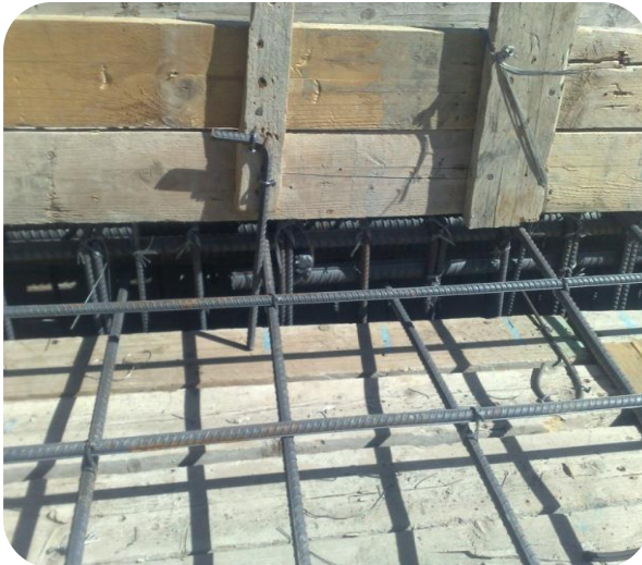
صوره (٢-١٨١) توضح عمل الهوا بط في البلاطات العادية (بحث ٢٠١٢-٢٠١٣م)
