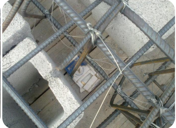
صورة (٢-١٨٨) توضح الشوائب التي يجب إزالتها من السقف قبل الصب (الباحث-٢٠١٣/٢٠١٤م)
