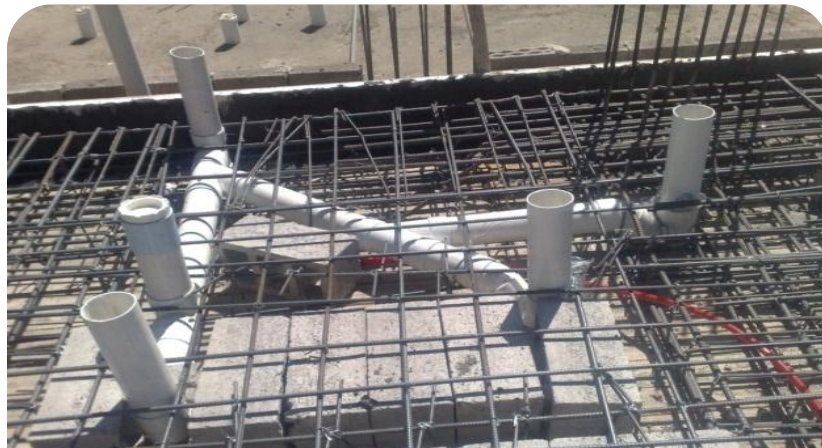
صوره (٢-١٨٢) توضح الشكل النهائي لشبكة الصرف في الأسطح الهريدي (بحث ٢٠١٢-٢٠١٣)
