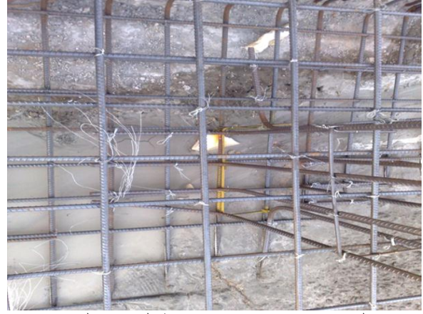
الصورة (٦١-٢) توضح ربط الرقاب بالقواعد (دراسة سابقة ٢٠١٢ - ٢٠١٣ م)
