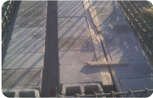
صورة (١٥١-٢) توضح رص البلك الهوردي (الباحث - ٢٠١٣ - ٢٠١٤م)
