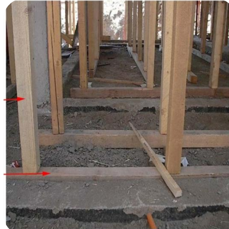
صورة (١٤٤-٢) توضح الفرشات أسفل الدعم (المؤسسة العامة للتعليم الفني والتدريب المهني "ورش شدات ووحدات تسليح باب الشدات الخشبية، المملكة العربية السعودية)
