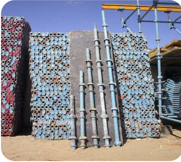
صورة (٢-١٦١) توضح الأطوال المختلفة للقوائم (المؤسسة العامة للتعليم الفني والتدريب المهني "ورش شدات ووحدات تسليح باب الشدات المعدنية، المملكة العربية السعودية)
