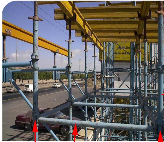
صورة (١٦٥-٢) توضح البرندات (العوارض الحديدية) في الشدة المعدنية (مرجع الصورة السابقة)
