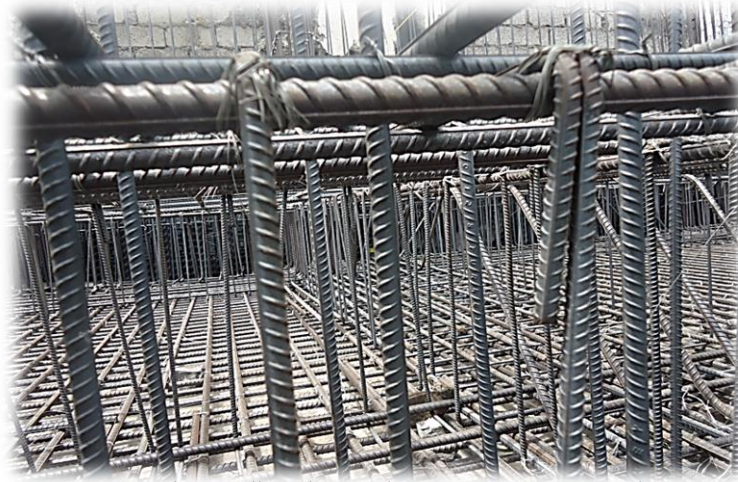
الصورة (٩٢-٢) توضح التبريط الجيد للحديد -الباحث ٢٠١٢-٢٠١٣ م
