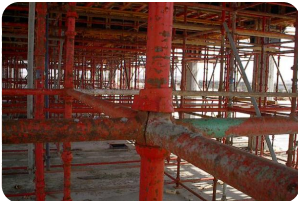
صورة (٢-١٦٣) توضح الكابات (الشكالات) في الشدة المعدنية (مرجع الصورة السابقة)
