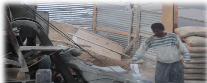
الصورة (٩٩-٢) توضح إضافة مادة السيكال للخلطة الخرسانية لمقاومة الأملاح-الباحث ٢٠١٢-٢٠١٣م
