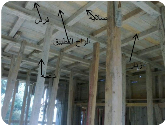
صورة (١٤٥-٢) توضح مكونات الشدة الخشبية من أسفل (الباحث- تنفيذ جامع الوقيان -قحز- إ-ب) (٢٠١٣-٢٠١٤ م)
