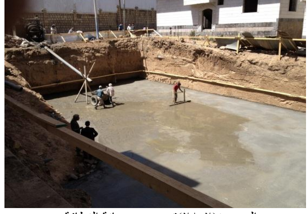
الصورة (٢-٢٨) توضح خرسانة النظافة فوق أحجار الجعم (الباحث-٢٠١٣-٢٠١٤)
