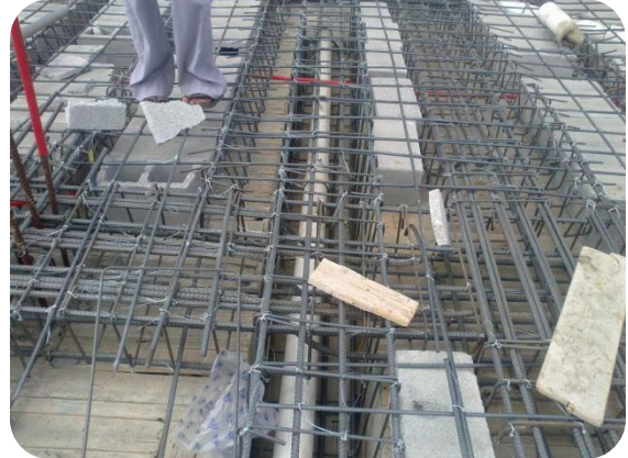
صورة (٢-١٧٨) توضح ماسورة التمديد داخل النفق الأفقي (الباحث ٢٠١٣/٢٠١٤م)
