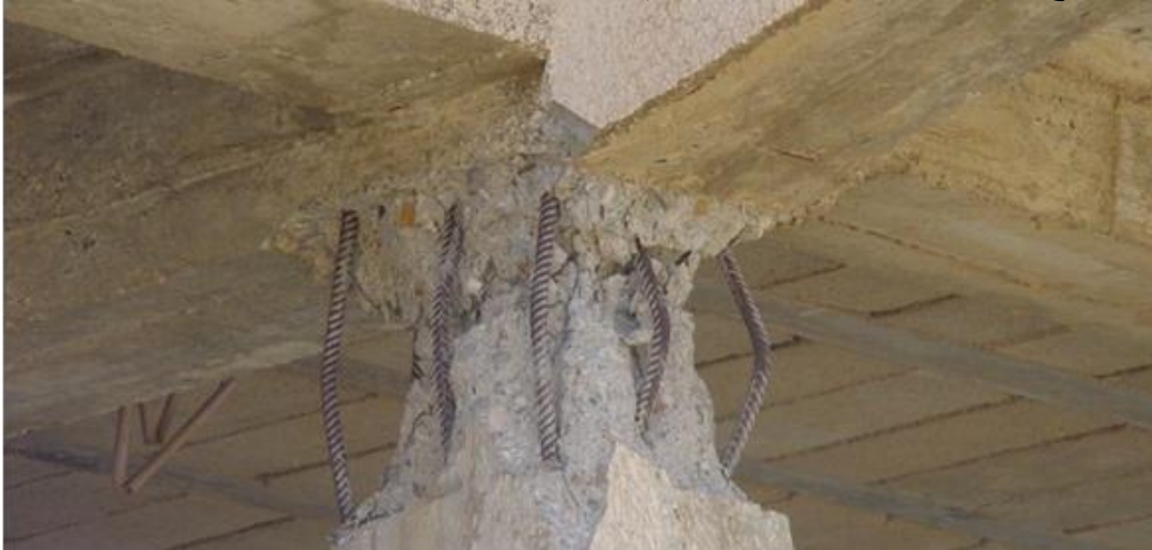
صورة (٢-١٠٩) توضح عدم استمرار الكانات داخل مناطق التقاء الأعمدة بالكمرات (ملتقى المهندسين العرب)
