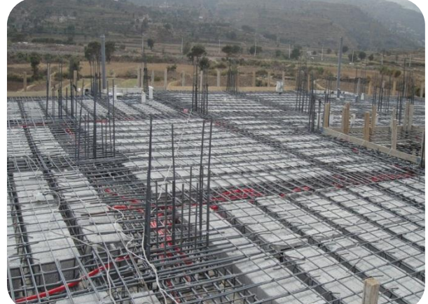
صورة (٢-١٨٩) توضح الوضع النهائي للسقف قبل الصب (أرشيف الباحث)
