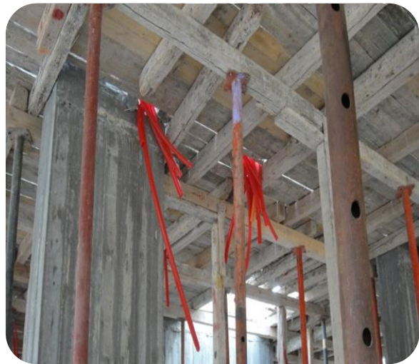
صوره (٢-١٨٦) توضح مواسير الكهرباء - بحث عام ٢٠١٢-٢٠١٣م
