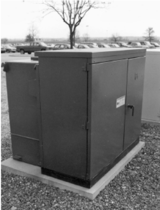
الشكل (14) المحولات المثبتة علي وسادة أرضية
