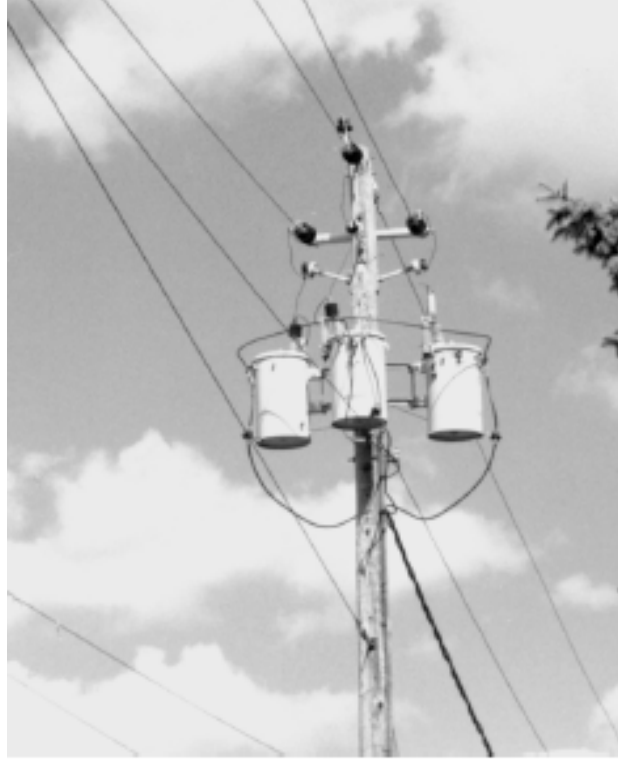
شكل (20) ثلاث محولات وجه واحد متصلة لتكون محول ذي ثلاثة أوجه
