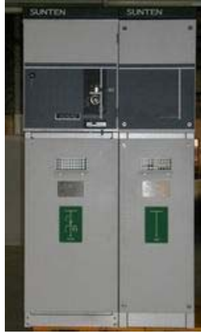
الشكل (11) الوحدة الأساسية الحلقية المدمجة
