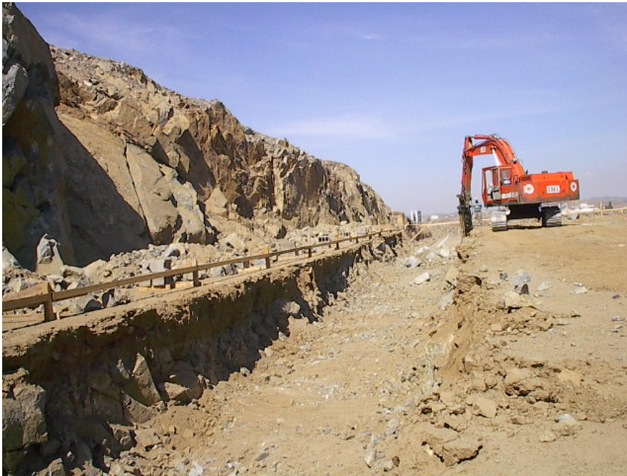
شكل رقم (٩) الحفر في تربة صخرية سهلة التفكك
