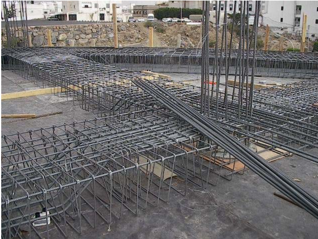
شكل رقم (٢٣) يبين أعمال الحديد لسقف من البلاطات المفرغة
