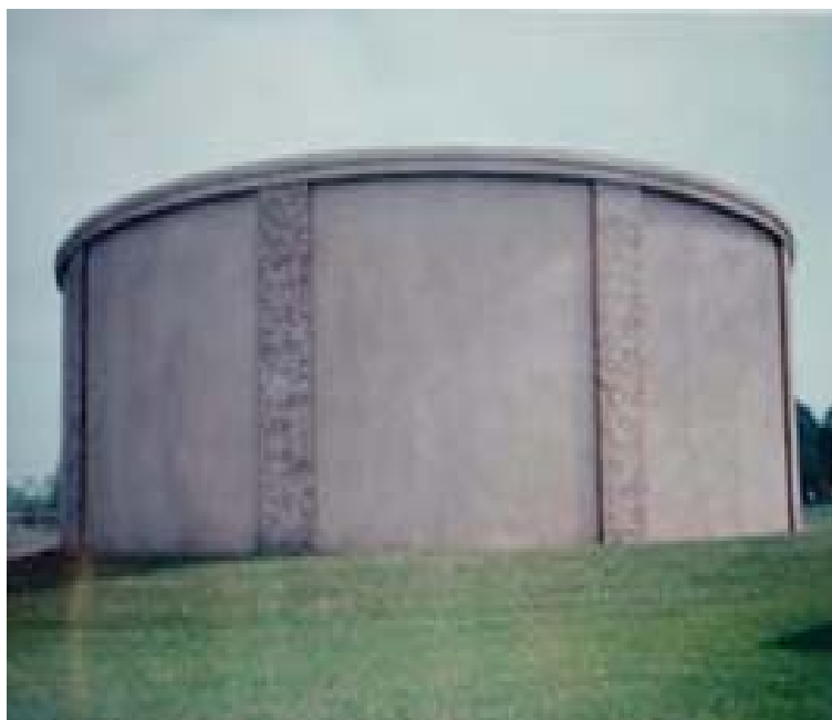
شكل (٩,٢): خزانات منشأة من الخرسانة المسلحة.
