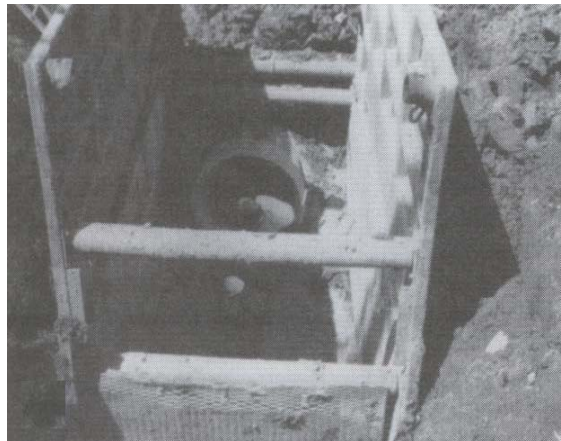
شكل (٩،٤): مراحل تنفيذ مواسير التصريف.
